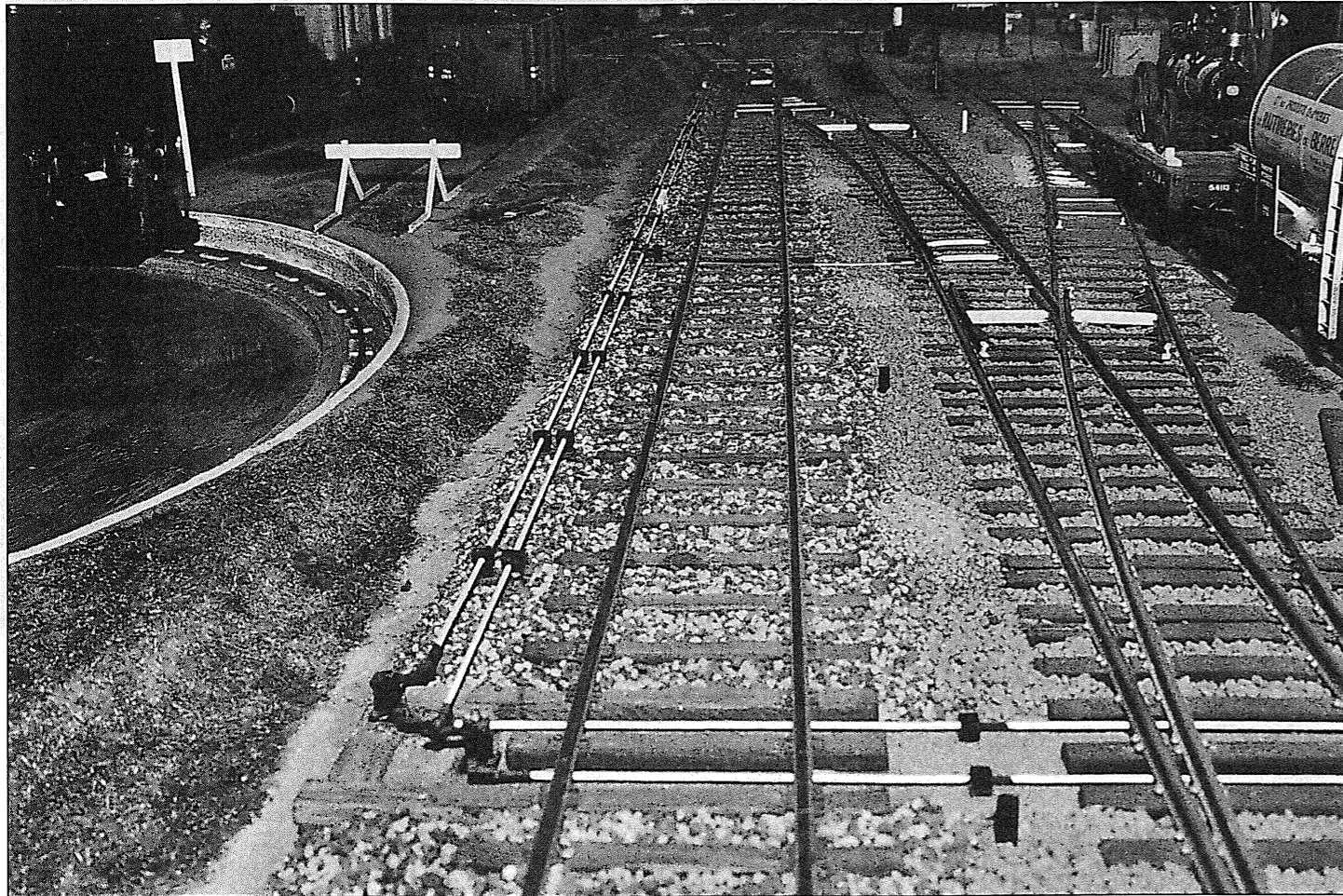
Alignement de voies, grill sud, sur le réseau de Bernard Fieyre. Photo B.F.
