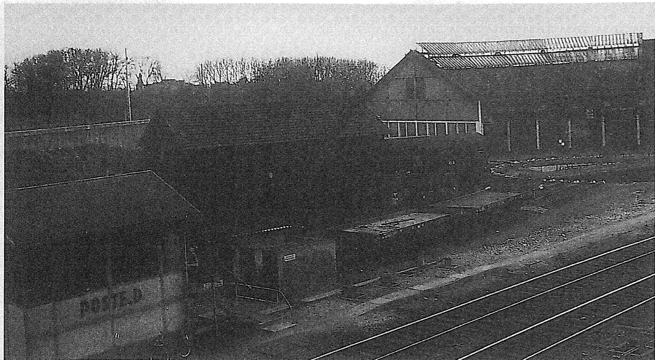
Ci-dessus : Bourges : poste D côté Saincaize. Noter le velosolex. Un FNC est garé sous la remise. Au centre, l'atelier de réparation des wagons.
