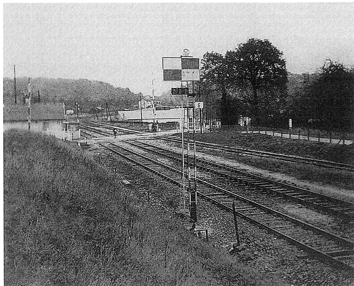
Ci-dessous, photo 7 : Domfront, 1969. Carré Ouest à feux électriques. A l'arrière plan, le PN à barrières oscillantes.
